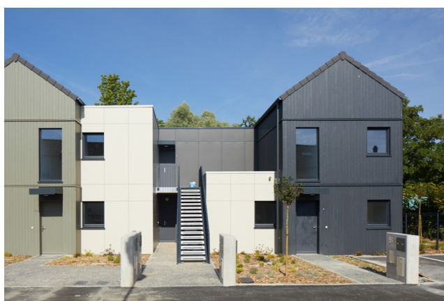
façades rue, est
