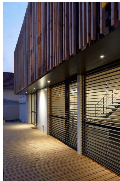
la sous-face du débord de façade
